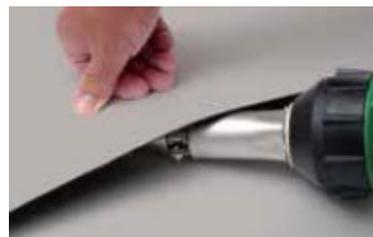
**PRÉ-SOUDURE :** Il s'agit d'une soudure linéaire en retrait par rapport au bord du revêtement supérieur.
