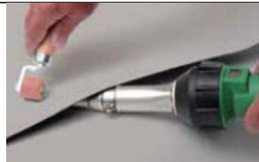
**SOUDURE FINALE :** Il s'agit de la soudure du bord du revêtement supérieur sur le revêtement inférieur.
